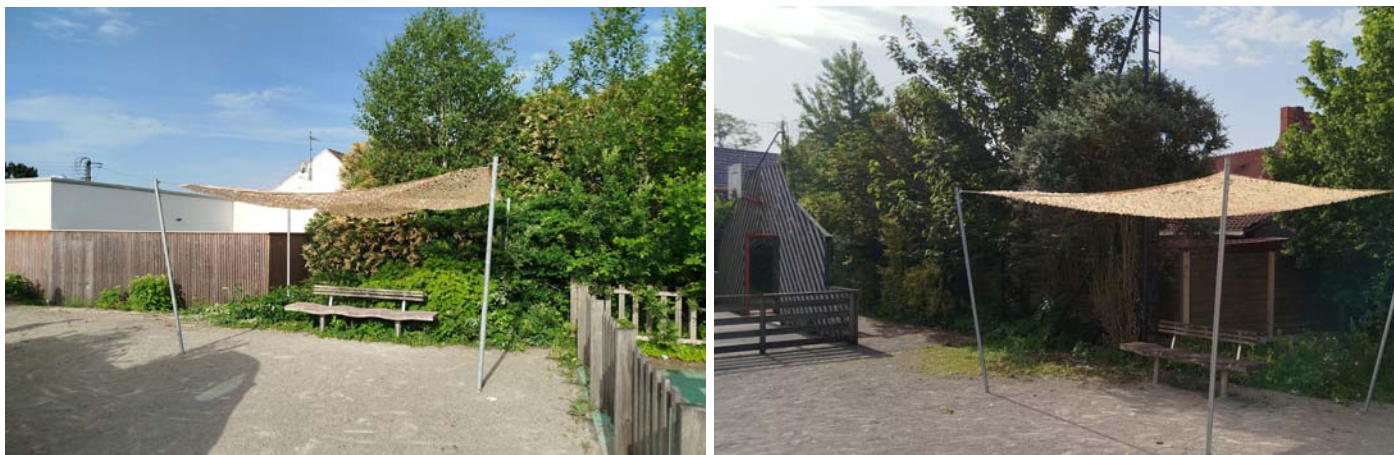
Installation des voiles d'ombrage dans le petit parc de la mairie.
