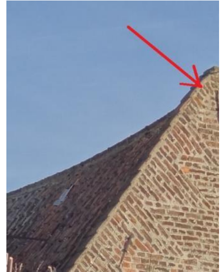
Wambergues : dépassement du pignon pour protéger la toiture des vents (évite le décollement des tuiles)
