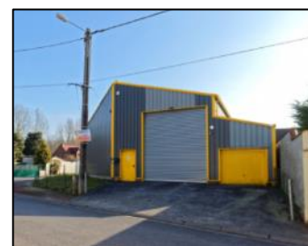
Bâtiment qui accueillera la future halle multi-activité
